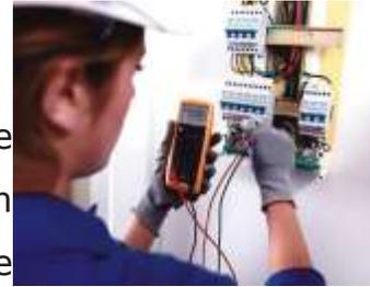
El multímetro es un aparato que incluye dos cables (rojo y negro), que se colocan en los dos puntos del circuito donde se quiere realizar la medida. También posee una rueda que, según la posición, mide el voltaje, la intensidad o la resistencia.
